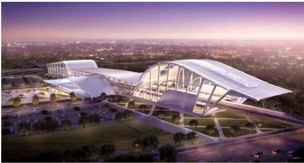
ภาพเสมือนจริงของสถานีเมืองบันดาร์ ประเทศมาเลเซีย ถือเป็นรถไฟความเร็วสูงแห่งแรก สายกัวลาลัมเปอร์และสิงคโปร์ในอนาคต
